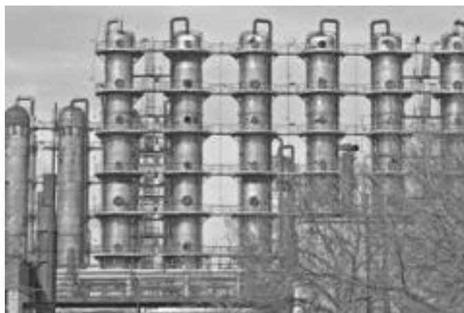
Рисунок 4.3 – Реактори колонного типу (ліворуч) на нафтохімічному заводі. Праворуч показані ректифікаційні колони.
