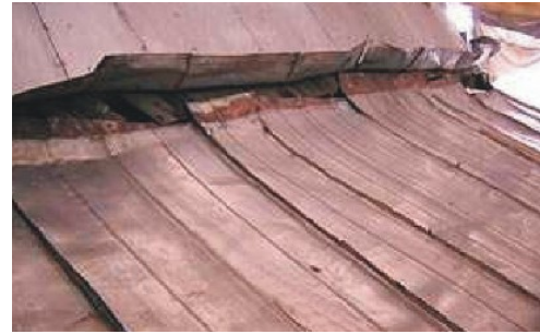
Рис. 4.2. Підготовка до розбирання покрівельного покриття (другий спосіб)
