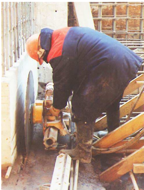
Рис. 4.17. Розширення отвору з використанням технології алмазного різання
