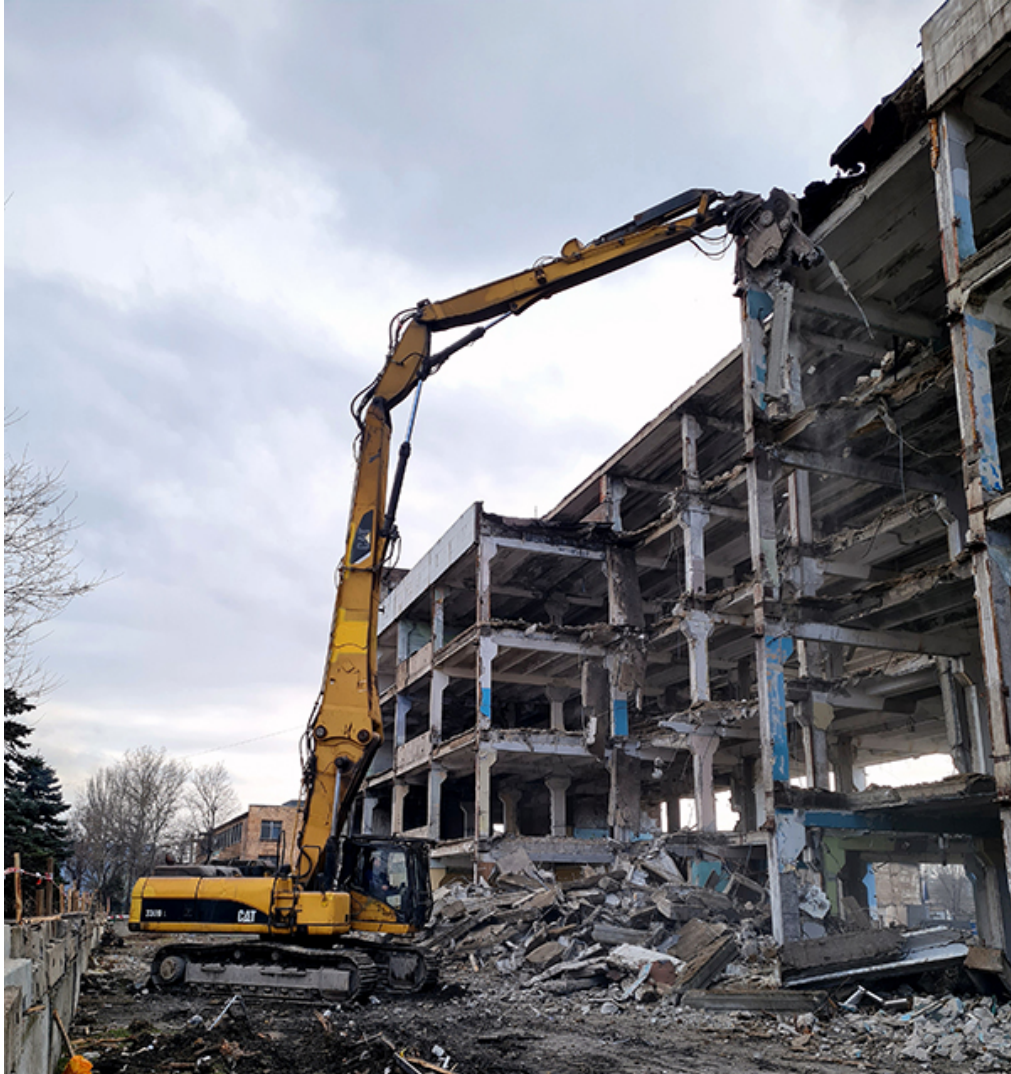
Рис. 4.12. Руйнування конструкцій будівлі екскаватором, який оснащено гідравлічними ножицями
