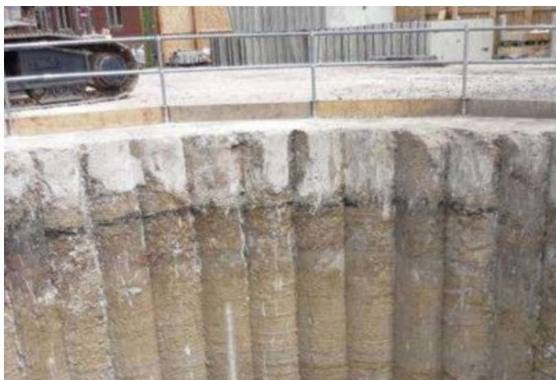
Рис. 6.6. Огороджування стінки котловану з ґрунтоцементних паль
