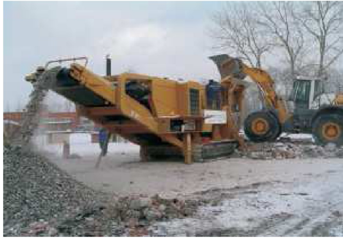
Рис. 4.14. Робота мобільного дробильного комплексу при переробці будівельних відходів
