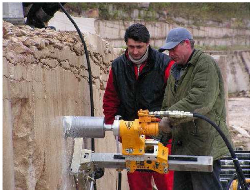
Рис. 4.18. Свердління бетону з використанням технології алмазного різання
