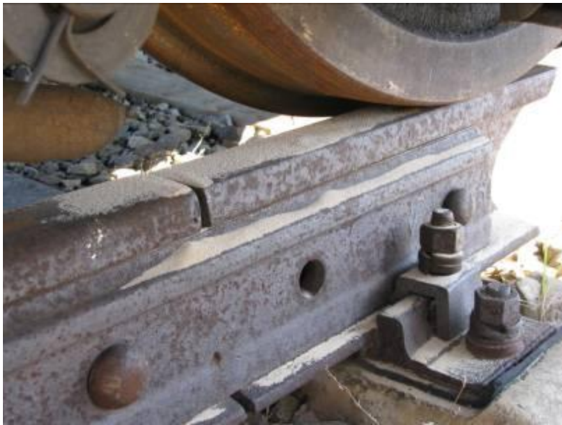
Рисунок 3 – Засмічення пружних прокладок
