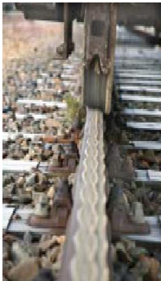
Рисунок 2 – Залишок піску на рейках після проходження останнього вагона
