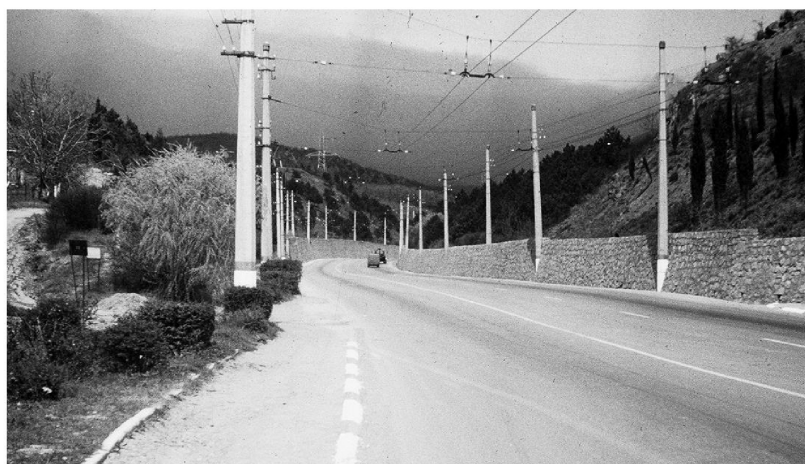
Рисунок 8.4 – Захист автомобільної дороги підпірною стінкою
