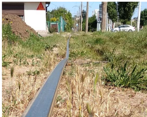
Рис. 3. Длинные неровности пути в продольном профиле в эксплуатации
