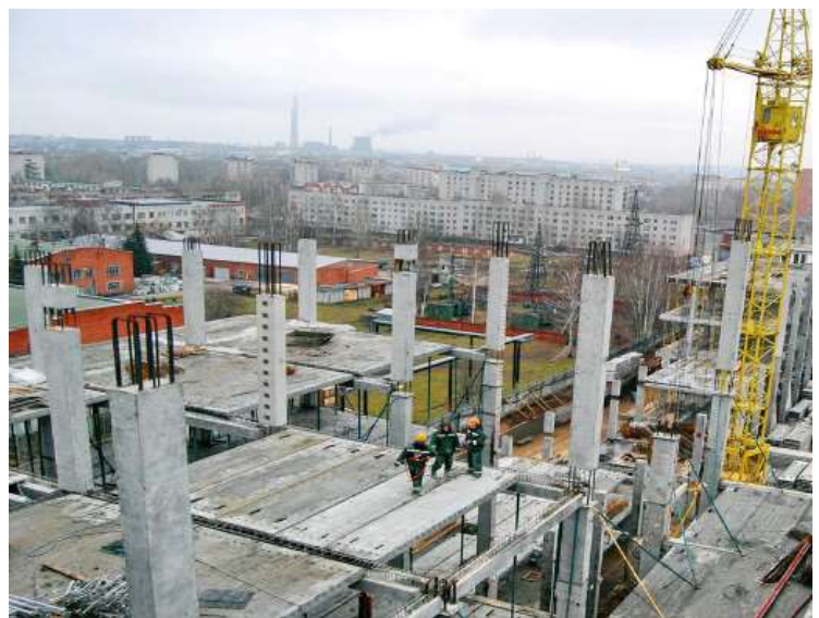
Рис. 4.11. Будівлі монолітної та збірно-монолітної будівельних систем: а – з монолітним залізобетонним каркасом; б – зі збірними залізобетонними колонами і плитами перекриттів та збірно-монолітними ригелями
