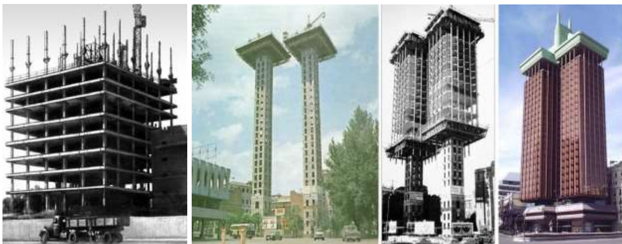
Рис. 4.17. Зведення будівель методом підйому покриттів (поверхів)
