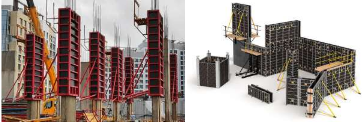
Рис. 4.14. Зведення будівлі методом крупнорозмірної щитової (крупнощитової) опалубки
