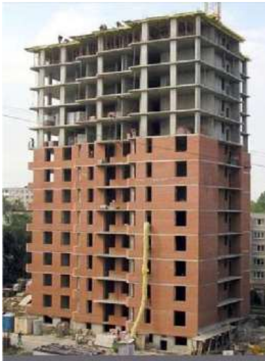
Рис. 4.11. Будівлі монолітної та збірно-монолітної будівельних систем: а – з монолітним залізобетонним каркасом; б – зі збірними залізобетонними колонами і плитами перекриттів та збірно-монолітними ригелями
