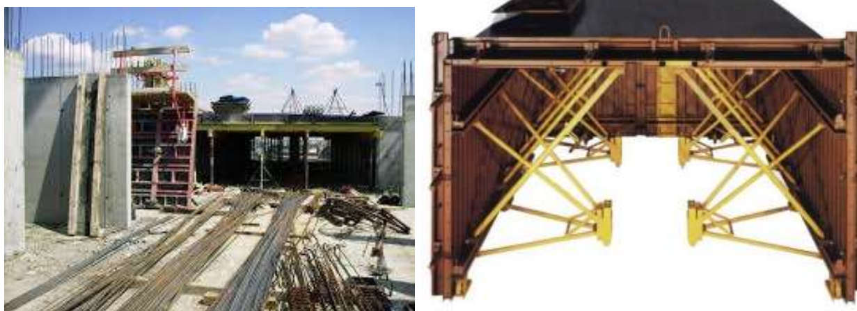
Рис. 4.12. Зведення будівлі методом об'ємно-переставної опалубки
