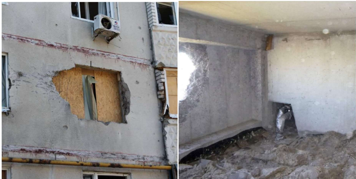
Рис. 2. Ушкодження конструкцій внаслідок влучення снарядів
