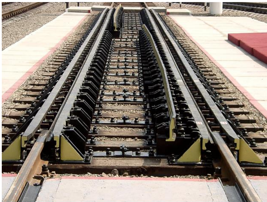
Рис. 1.16. Колієперевідний пристрій системи SUW2000 Fig. 1.16. Gauge changeover device of the SUW2000 system
