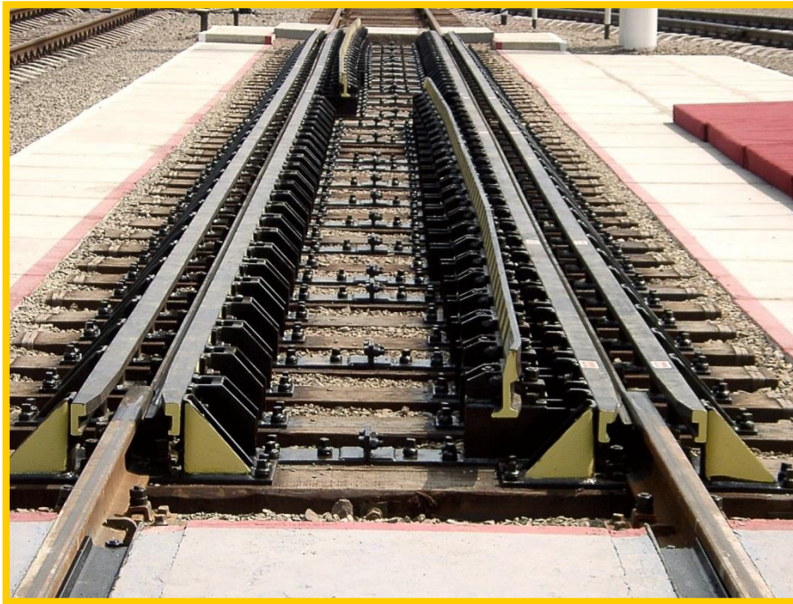
Рис. 7.4. Колієперевідний пристрій системи SUW2000
