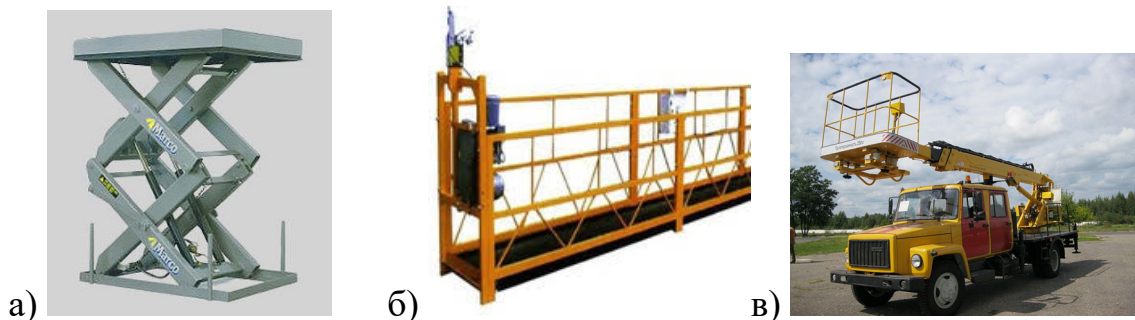
Рисунок 4.5 – Підйомні майданчики: а) наземний; б) підвісний (люлька); в) автовишка.
