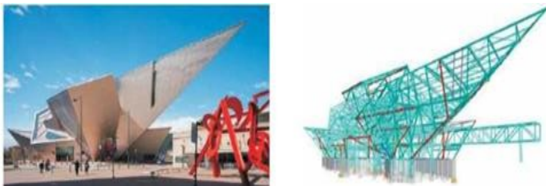
Рисунок 3 - BIM сталевого каркасу та фасад Музею мистецтва у Денвері, США, архітектурне бюро D. Libeskind, 2006 р.
