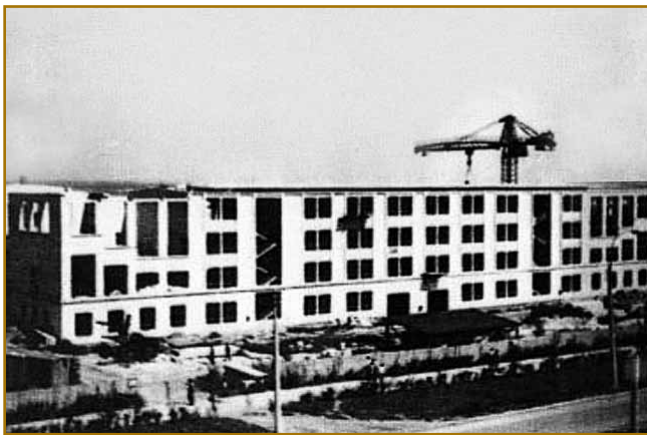
Будівництво першого корпусу
