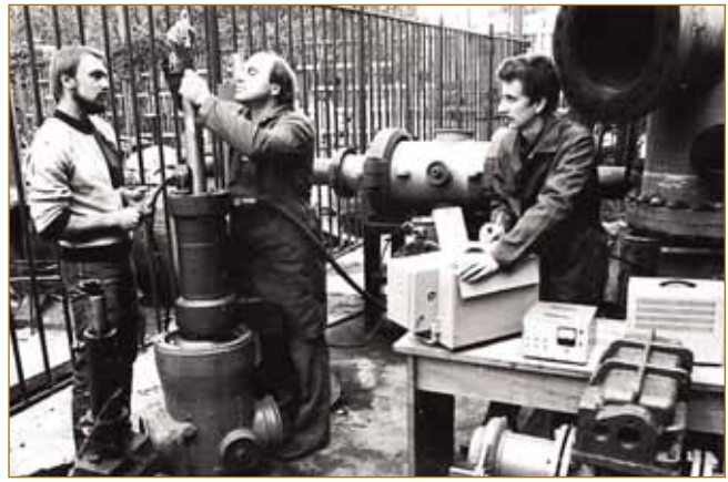
Випробування трубопровідної арматури
