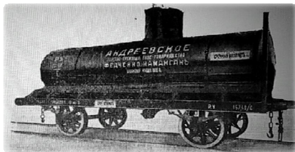
Рис. 4. «Нормальна» цистерна для перевезення нафти та олії 1895 р.
