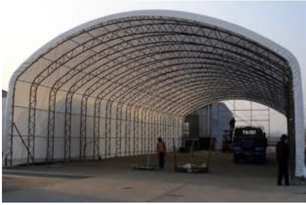
Рис. 1.8. Розпірні будівельні конструкції: а – арки; б – склепіння
