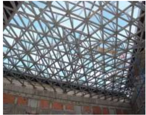
Рис. 1.11. Гратчасті будівельні конструкції: а – просторова ферма; б – просторові грати
