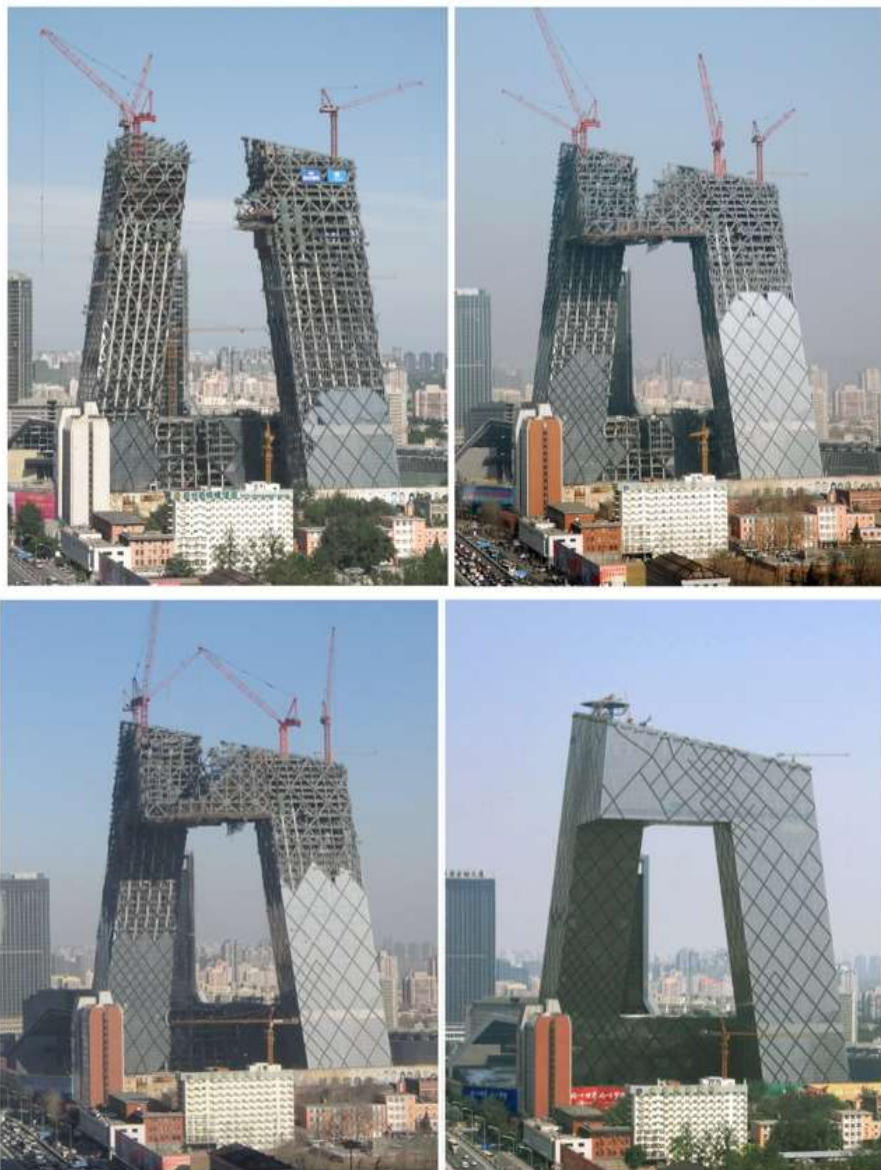
Рис. 5.11. Зведення будівлі Центрального телебачення Китаю, Пекін
