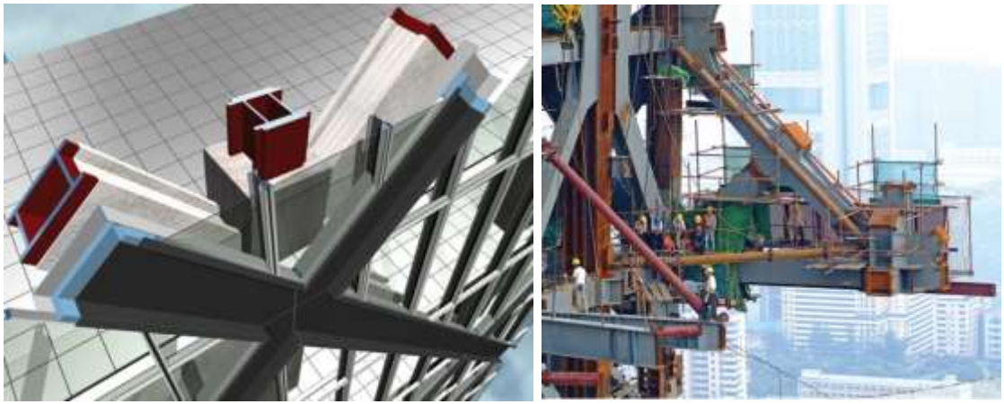
Рис. 5.10. Конструктивне рішення фасадної системи (а) та монтаж консольної перемички (б)
