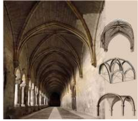
Рис. 1.8. Розпірні будівельні конструкції: а – арки; б – склепіння
