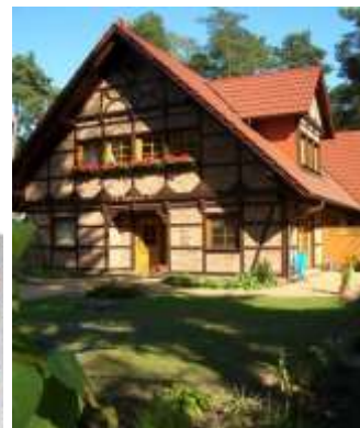
Рис. 1.1. Дерев'яні будинки: а – з брусу; – каркасний; в – фахверковий
