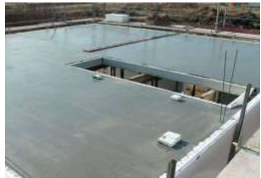
Рис. 1.10. Суцільні будівельні конструкції: а – монолітні залізобетонні стіни; б – монолітне залізобетонне перекриття
