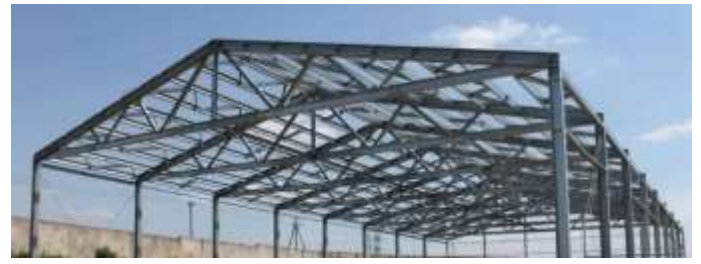
Рис. 1.6. Плоскі будівельні конструкції: а – плити перекриття; б – ферма
