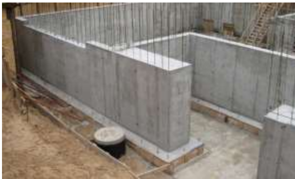
Рис. 1.10. Суцільні будівельні конструкції: а – монолітні залізобетонні стіни; б – монолітне залізобетонне перекриття
