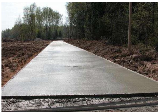
Рисунок 9.5 - Укладання і вирівнювання поверхні цементобетонного покриття.
