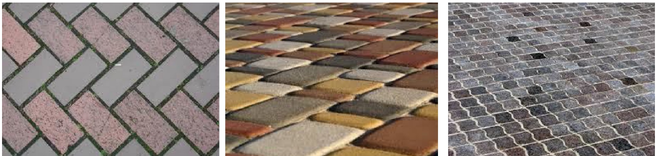
Рисунок 9.8 - Приклад покриття зі штучного каменю.
