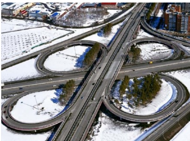
Рисунок 8.11 – Характерний приклад повної транспортної розв'язки типу «лист конюшини»
