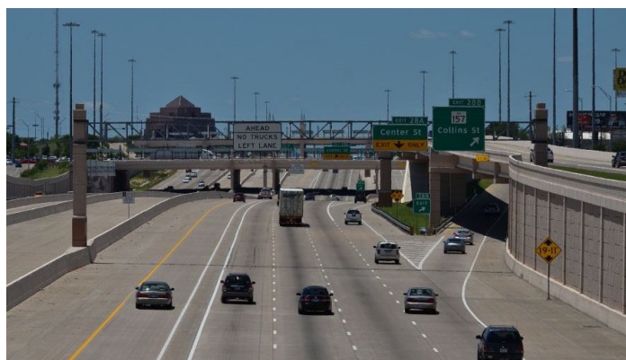
Рисунок 9.6 - Приклад готового цементобетонного покриття швидкісної дороги (США).
