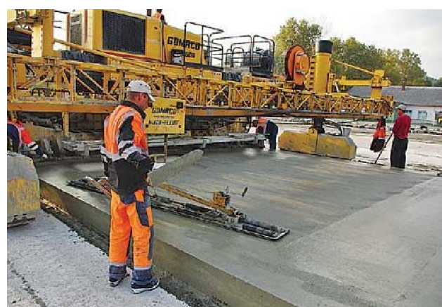
Рисунок 9.5 - Укладання і вирівнювання поверхні цементобетонного покриття.
