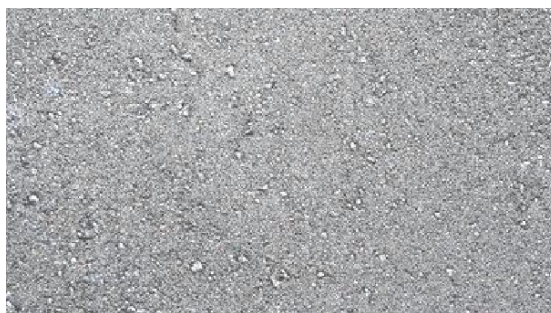
Рисунок 9.1 - Загальний вигляд асфальтобетонної поверхні
