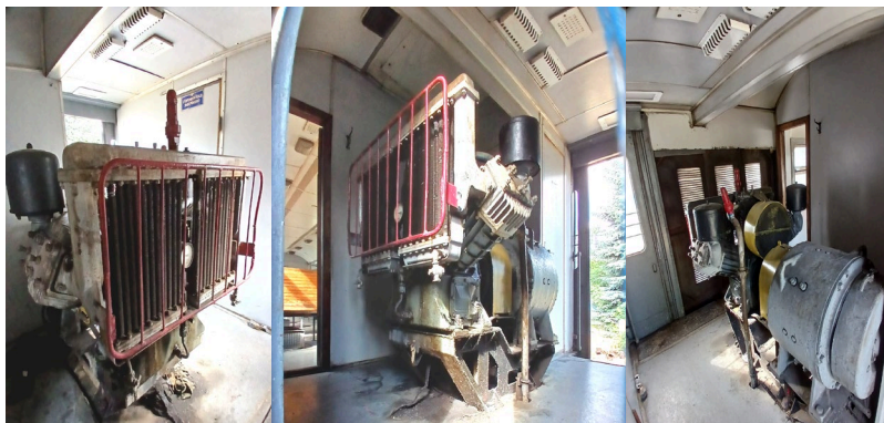
Рис. 4. Розміщення компресора КТ-6 в службовому тамбурі головного вагона електропоїзди ЕР-2
