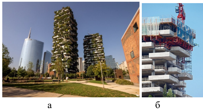
Рисунок 2. Bosco Verticale, м. Мілан (Італія): а – побудовані вежі; б – процес будівництва
