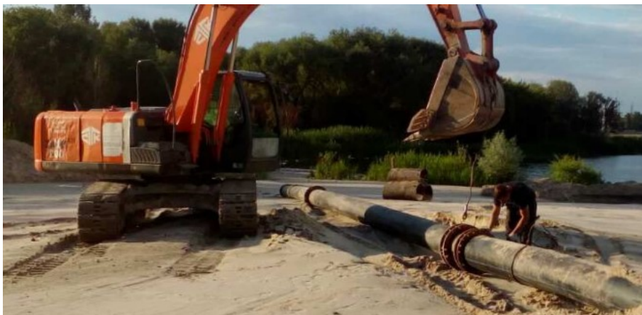
Рисунок 3. Укладка геотекстильних труб
