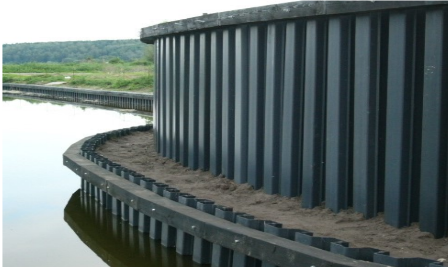
Рисунок 1. Закріплення берега шпунтом Ларсена
