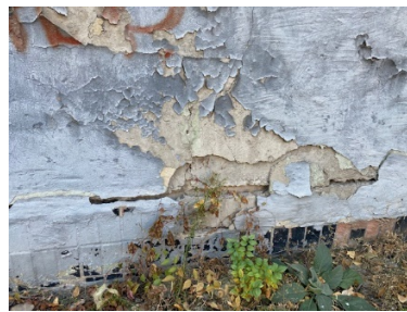
Рис. 2. Горизонтальні тріщини розкриттям до 2 см
