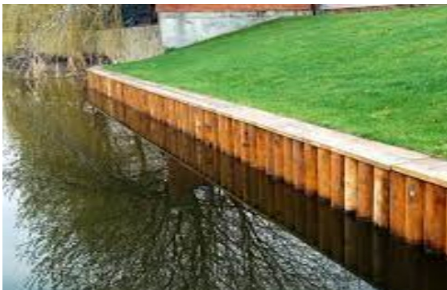
Рисунок 2. Закріплення берегу дерев'яним шпунтом
