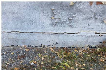
Рис. 2. Горизонтальні тріщини розкриттям до 2 см
