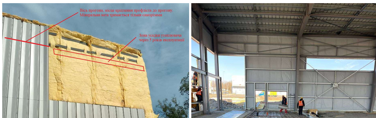
Рис. 1. Фото конструкції одношарової системи профільованого листа LPA900 з внутрішнім волокнистим утеплювачем INF 100 мм.
