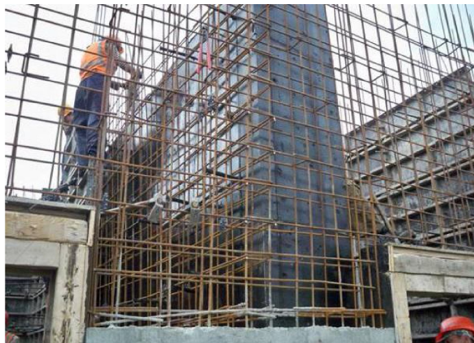
Рисунок 3.2 – Армування вертикальних стін
