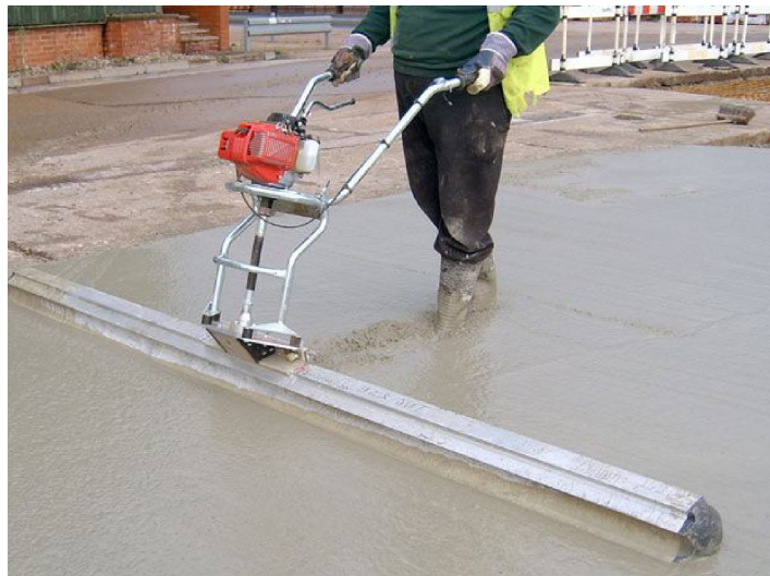
Рисунок 9.4 – Поверхнєве ущільнення бетону віброрейкою
