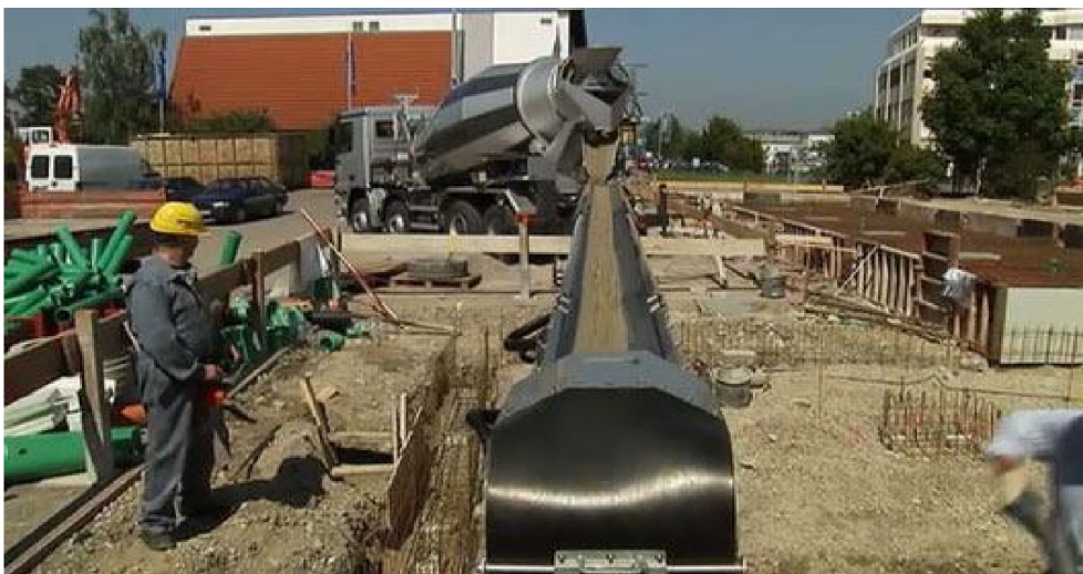
Рисунок 7.8 - Використання стрічкового конвеєра для укладання бетонної суміші
