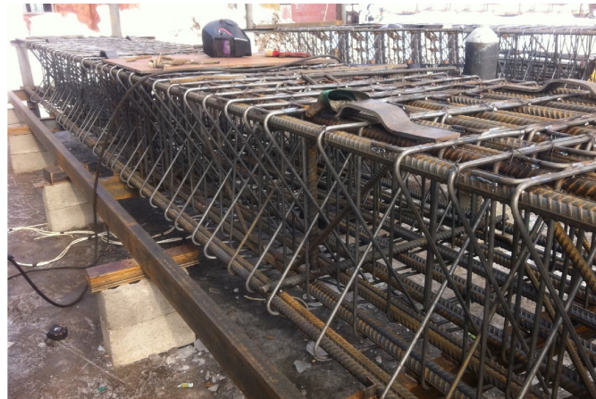
Рисунок 3.1 – Арматурні каркаси, підготовлені до монтажу
