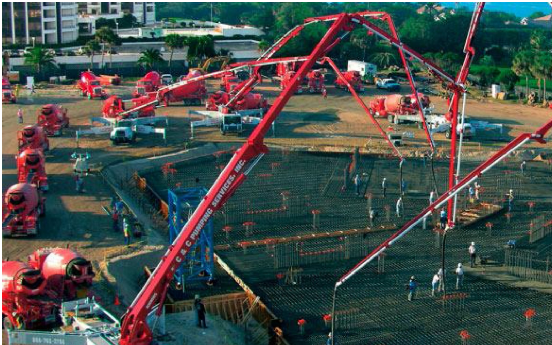
Рисунок 7.6 – Бетонування за допомогою автобетононасосів
