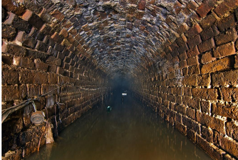
Рис. 4.14. Закритий канал з цегли
