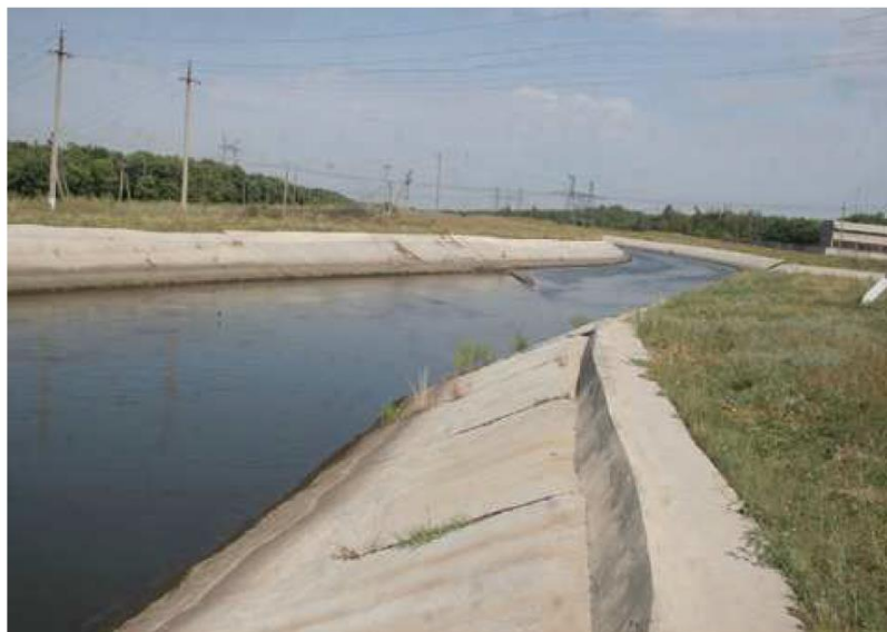
Рис. 4.15. Канал Сіверський Донець – Донбас на ділянці з облицюванням залізобетонними плитами
